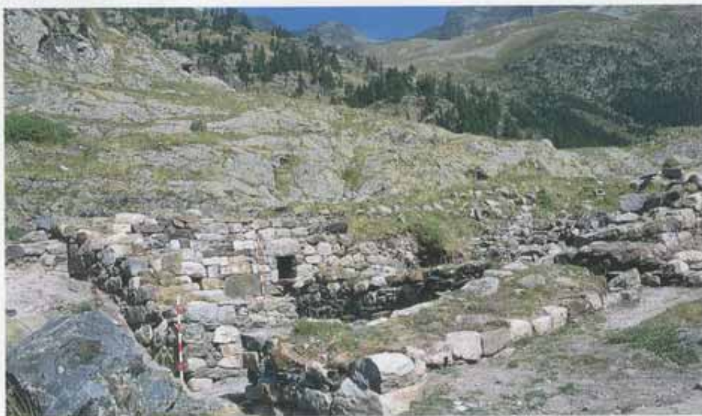
▲ Hospital Viejo de Benasque. El edificio de la "hospedería" tras su excavación y consolidación. Al fondo el camino del Puerto de la Glera. L'édifice de l'hospedería ou d'hôtelier après son excavation et sa consolidation. Au fond le chemin du Port de la Glera. (J.L.G.)
