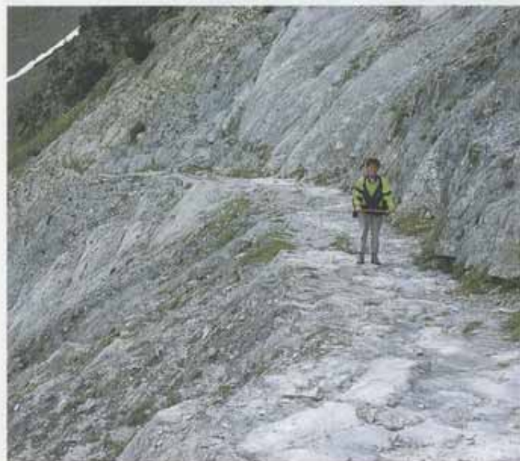
◀ El camino es "La Peña Blanca". Se construyó, a golpe de pico, habilitando una estrecha plataforma en la roca. El camino para la "Peña Blanca". Se construyó a golpe de pico, aménajando una larga plataforma en la roca. (J.L.O.)
