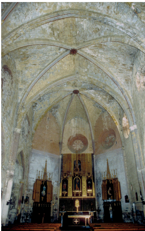
Bóvedas de crucería y cabecera poligonal de la iglesia de Molinos, de la que falta el retablo de finales del siglo XV
