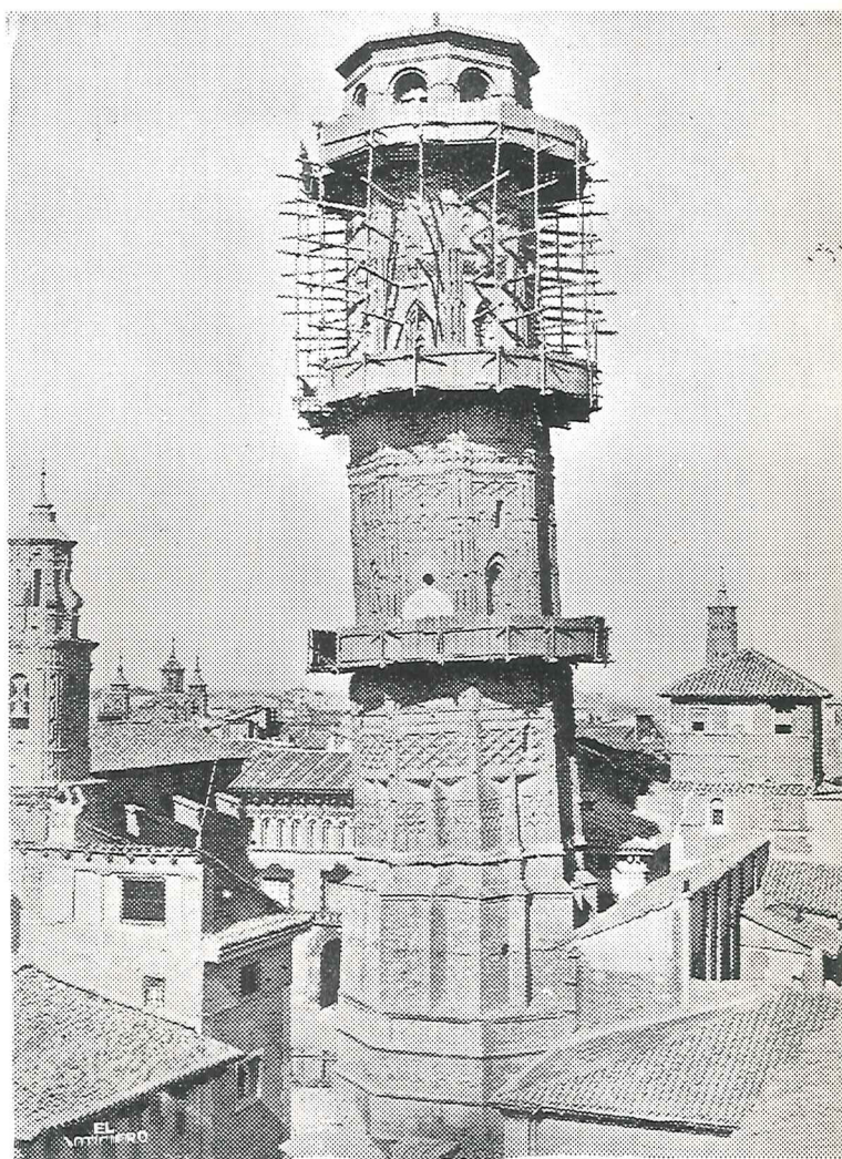
Preparada para el derribo...
