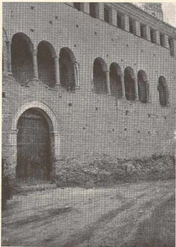
Fachada de la iglesia de Nuez
